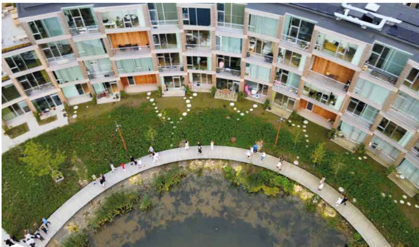
Bydelen Nye, udenfor Aarhus, er planlagt som en bydel ud fra en stærk vision om mere bæredygtig, naturbaseret byudvikling. På billedet ses de såkaldte "Sneglehuse" tegnet af BIG. Foto: Jonas Petri, Arkitektforeningen.
